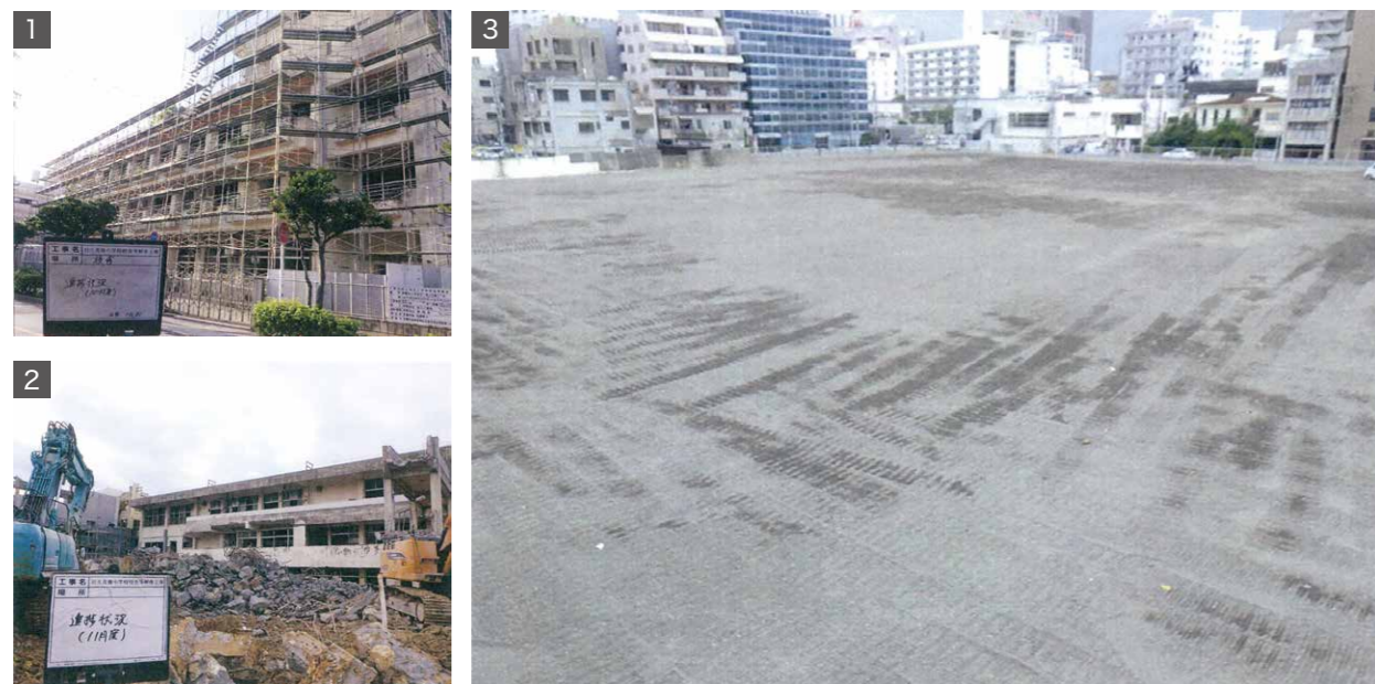
解体工事状況
