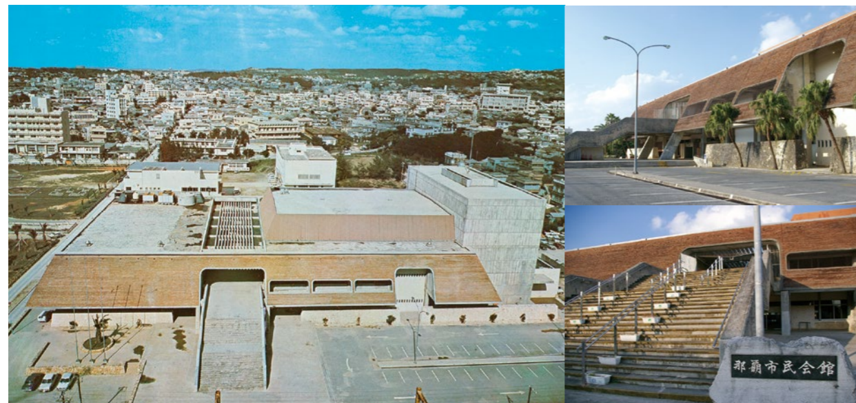
沖縄の伝統的建築物の要素を現代建築に取り込んだ意匠。 屋根の赤瓦、大きく張り出した屋根によるアマハジ、外部とロビーに配置されたひんぷん。
