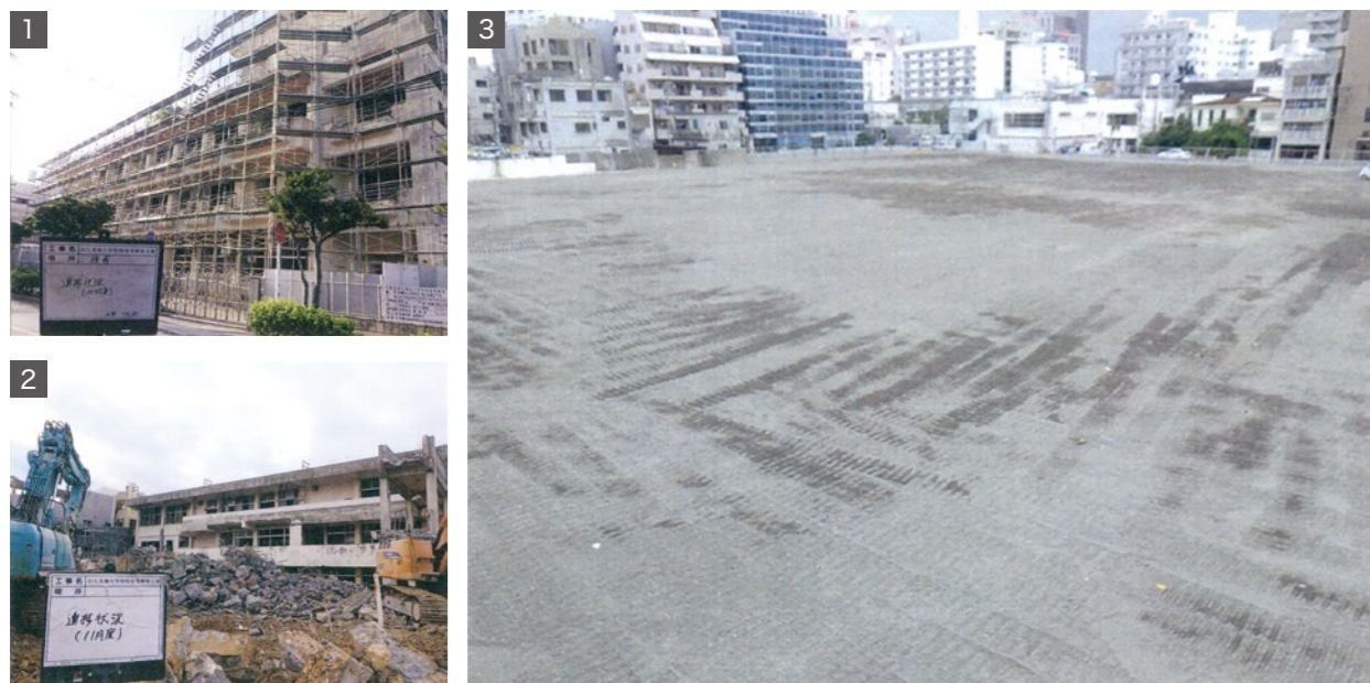
解体工事状況
